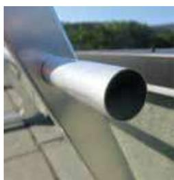
**La sous-lisse ronde Ø35 mm remplace la sous-lisse triangulaire pour toute la gamme VECTACO®. Ce changement entraîne les modifications sur les produits suivants :**
